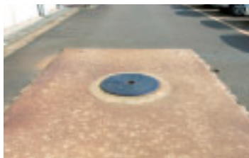
廃油は、地下タンクなどに回収した後、適正に処理されます
