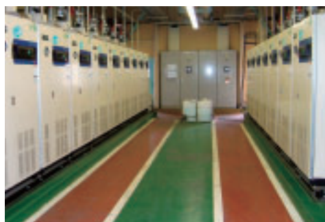
小型貫流ボイラー
