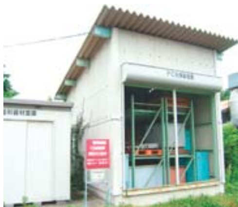
PCB廃棄物保管倉庫
