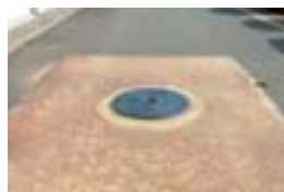
廃油は、地下タンクなどに回収した後、適正に処理されます
