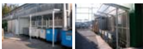
廃棄物置場に屋根を取り付け雨水の吹き込みを防止しています。
