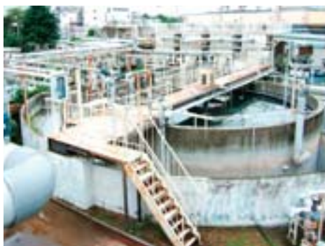
廃水処理施設
