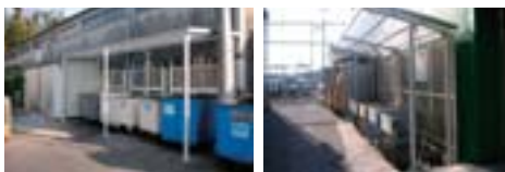
廃棄物置場に屋根を取り付け雨水の吹き込みを防止しています。
