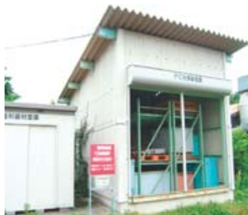
PCB廃棄物保管倉庫
